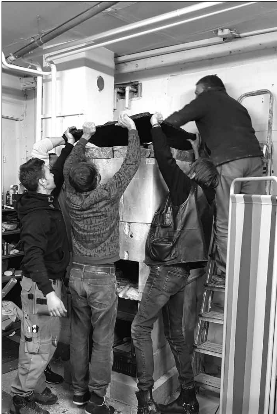
Ein Lehrer, ein Musiker und zwei Schreiner aus der nachbarlichen Schreinerei helfen dem Ofenbauer den Granitsteindeckel auf den Ofen zu hieven.
