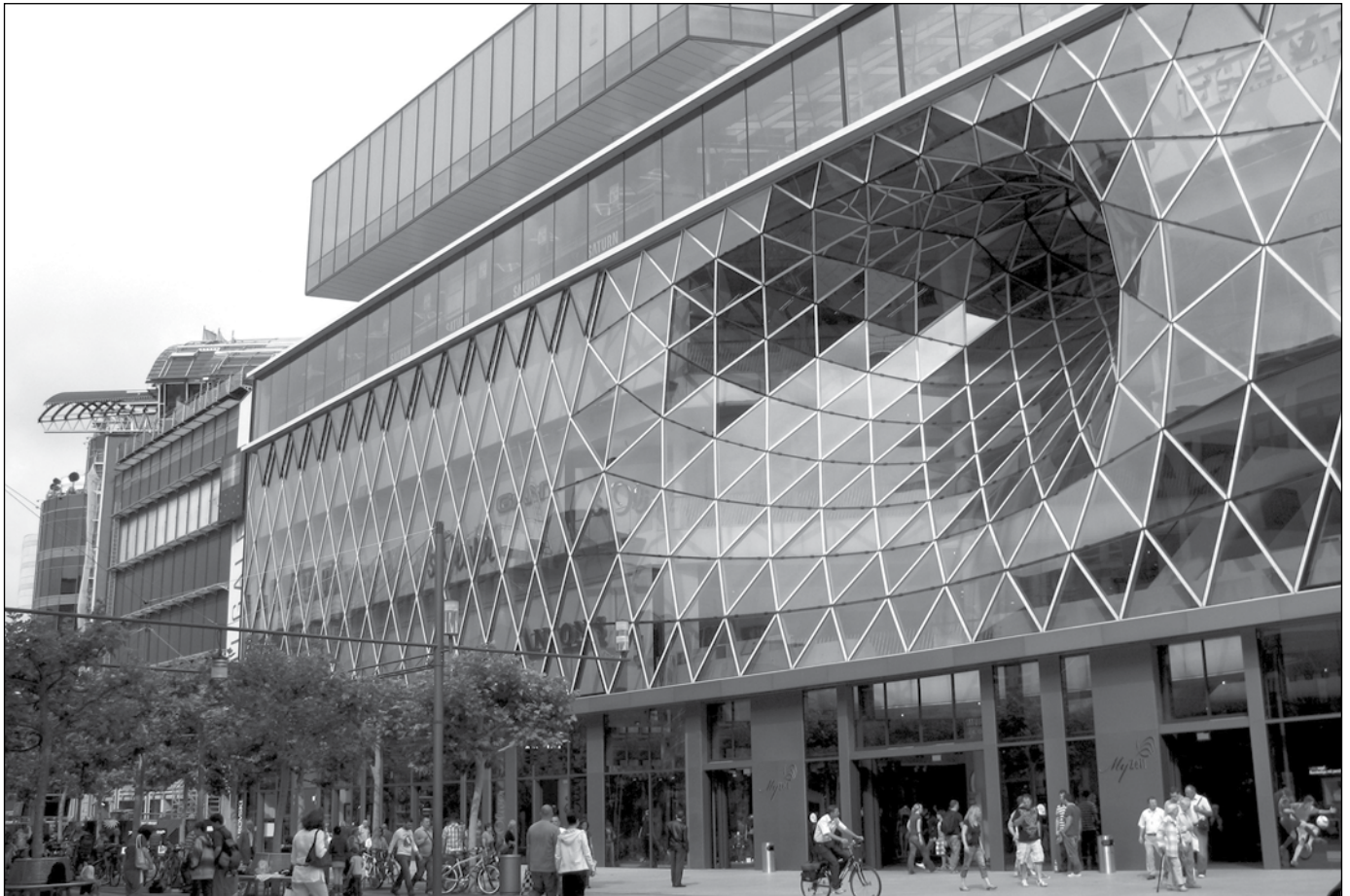
Einkaufszentrum MyZeil in der Innenstadt von Frankfurt am Main. Architekt ist der Römer Massimiliano Fuksas. Inzwischen steht MyZeil zum Verkauf. Bauliche Mängel, Mieterschwund, leere Ladenlokale....
